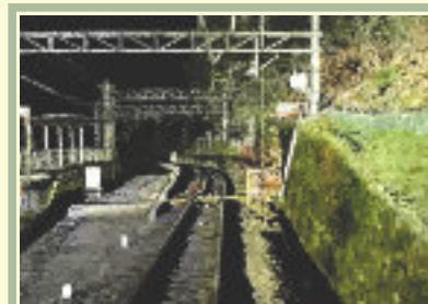
■ 駅舎の点群データ
