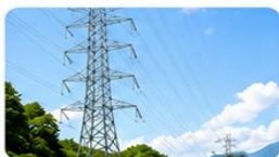
送電線・通信設備工事
