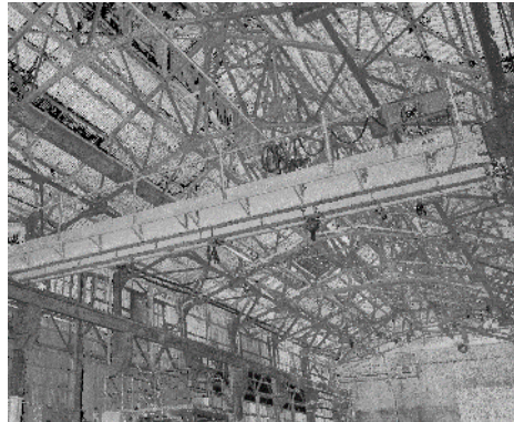
建屋内部構造計測
